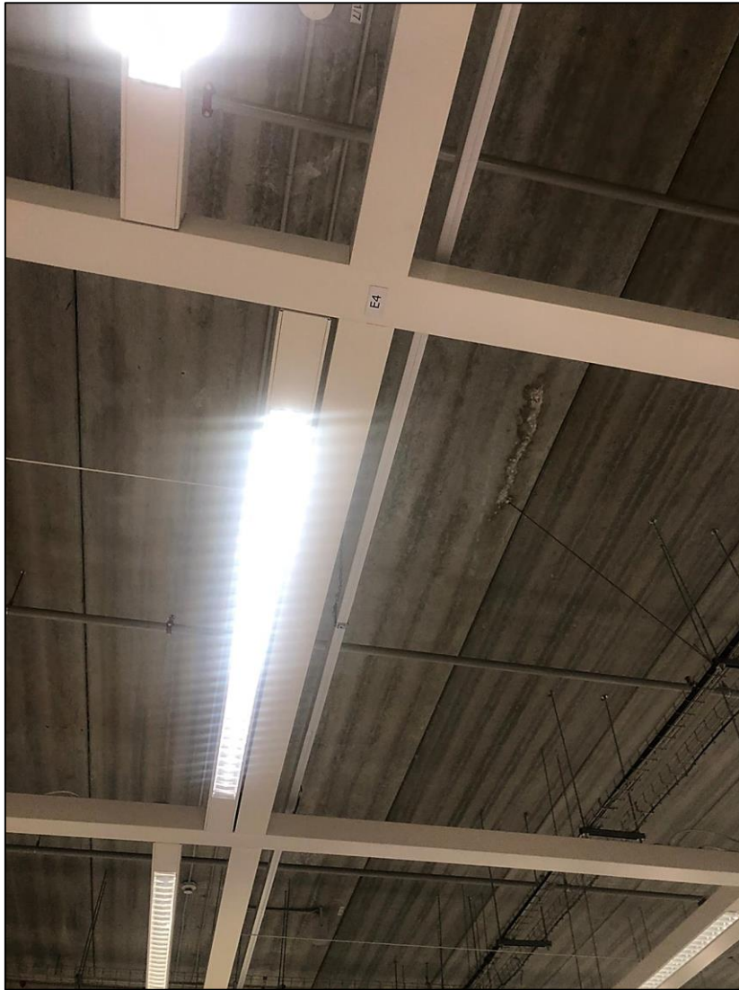
Slika 27. Dodatne oznake na konstrukciji Izvor: autor
