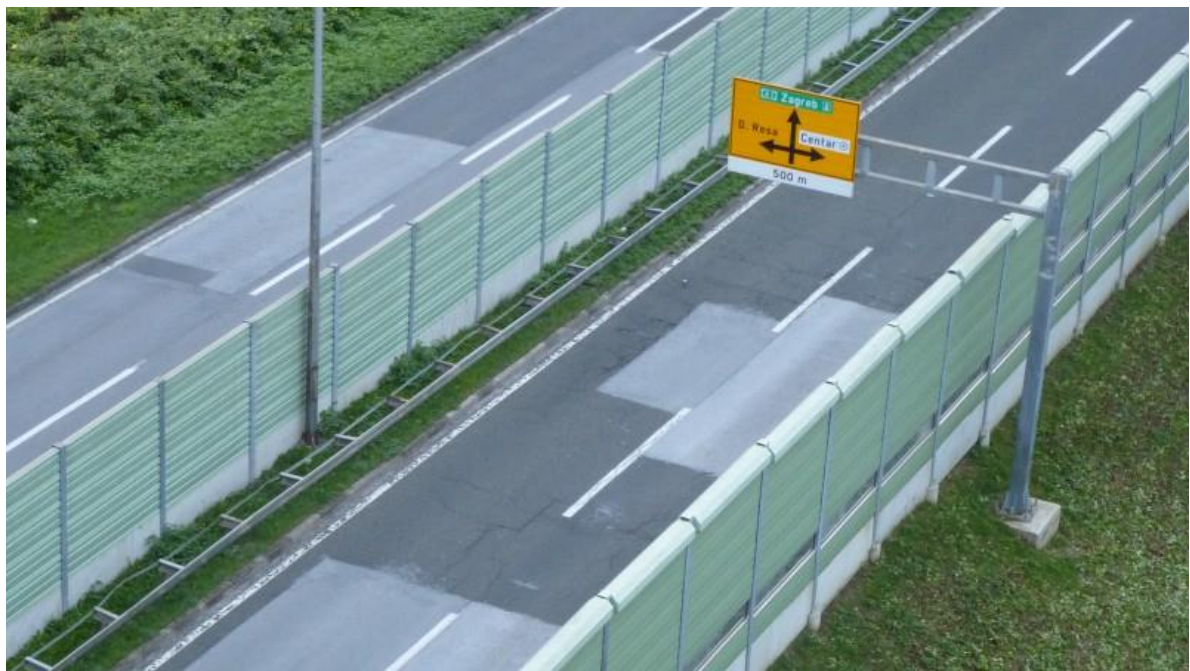
Slika 12: Uređaj za zaštitu od buke na autocesti
