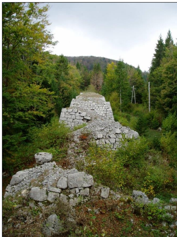
Slika 11. Dio Karolinske ceste sa sačuvanim ostacima kamenih potpornja ili fajera kod Brestove Drage (fajeri su bili potpornji stupovi drvenog mosta) [10]
