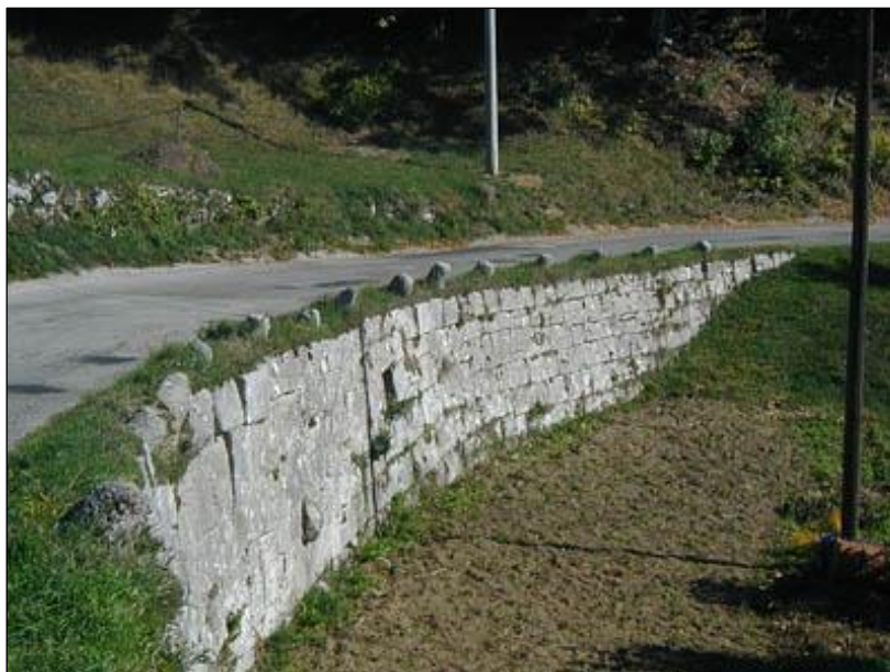
Slika 12. Dio Karolinske ceste sa sačuvanim podzidom[7]
