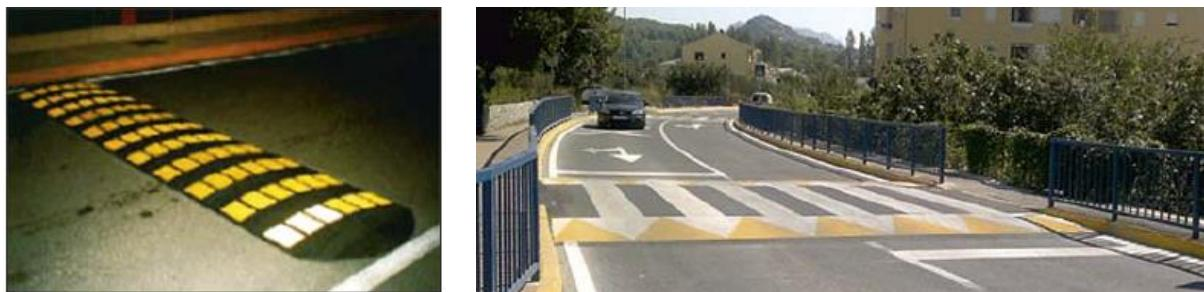
Slika 30. Primjer umjetne izbočine i uzdignite plohe kao mjera za smirenje prometa
