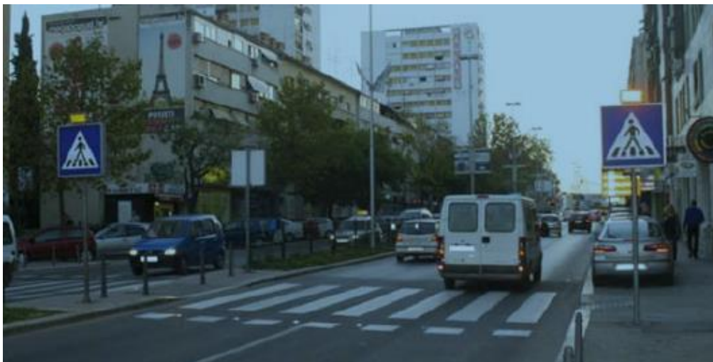
Slika 36. Povećanje sigurnosti na pješačkom prijelazu prometnom opremom i signalizacijom
