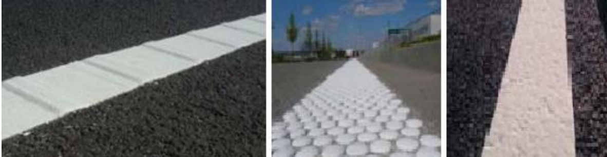
Slika 19. Profilirana, strukturirana i neprofilirana oznaka na kolniku
