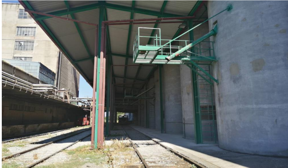
Slika 7 Utovarno mjesto za željezničke vagonne silosa „PIK Vinkovci d.d.“ u Vrapčani (Izvor: Autor)
