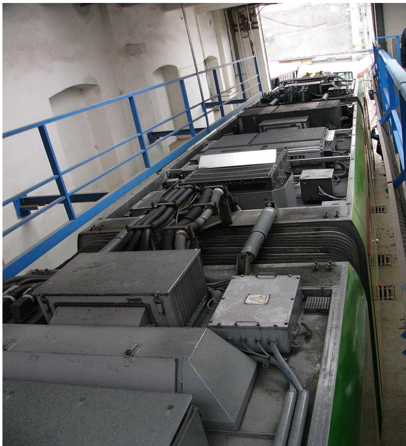
Slika 11 Mehanizam za regenerativno kočenje na krovu tramvaja Škoda [10]
