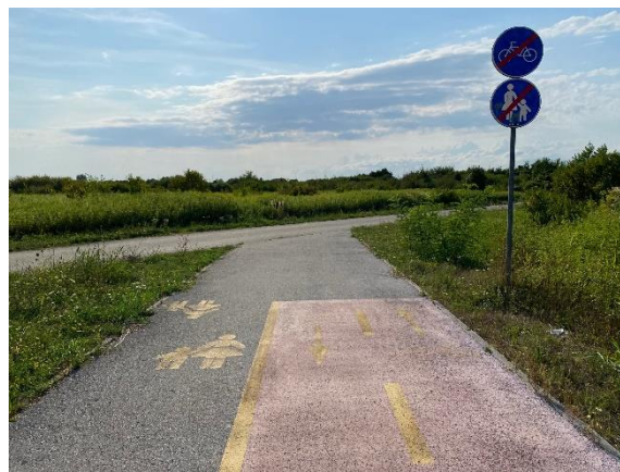
Slika 14. Prilaz prometnom čvoru Velika Kosnica
