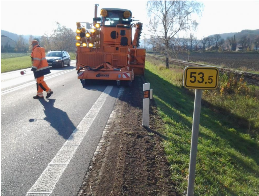
Slika 15: Strojno uređenje bankine
