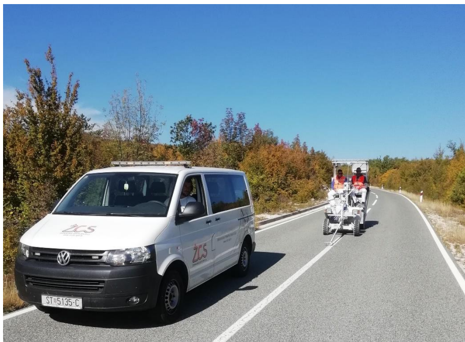
Slika 17: Bojanje uzdužne crte
