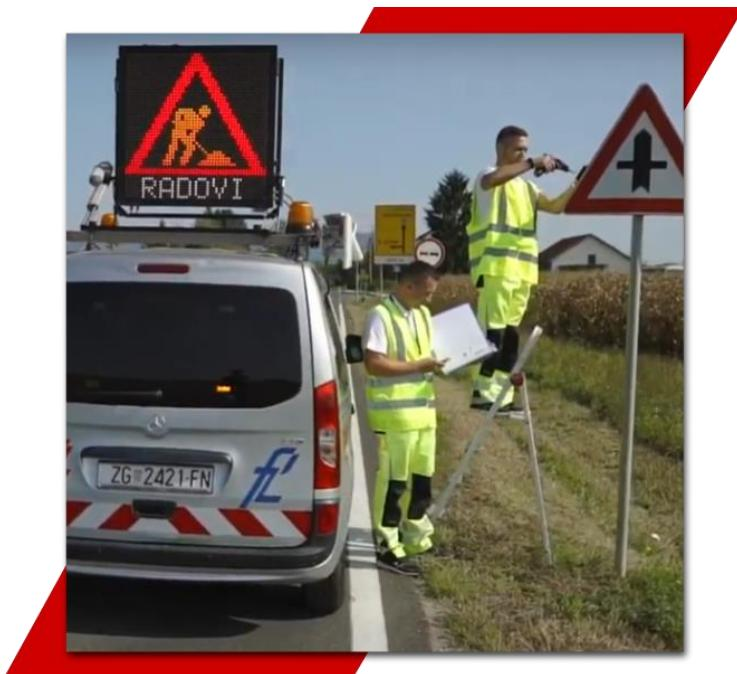
Slika 25: Očitavanje znakova RFID čitačem
