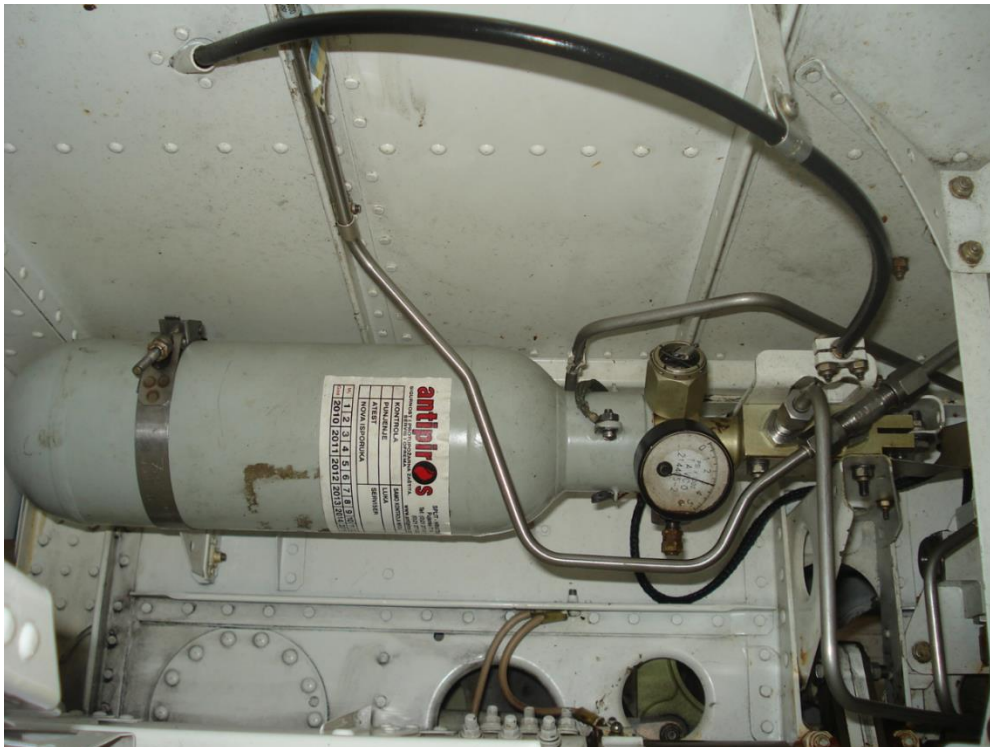
Slika 10. Spremnik dušika i manometar – sustav za slučaj nužde
