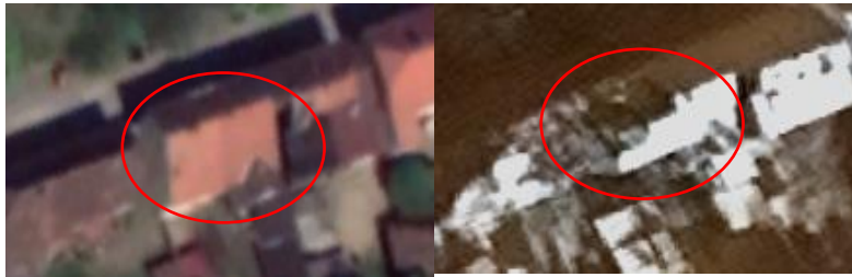
Slika 31. Objekt prikazan na snimkama prije i nakon potresa-2.primjer
