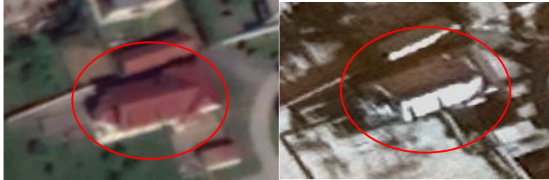
Slika 33. Objekt prikazan na snimkama prije i nakon potresa-3.primjer
