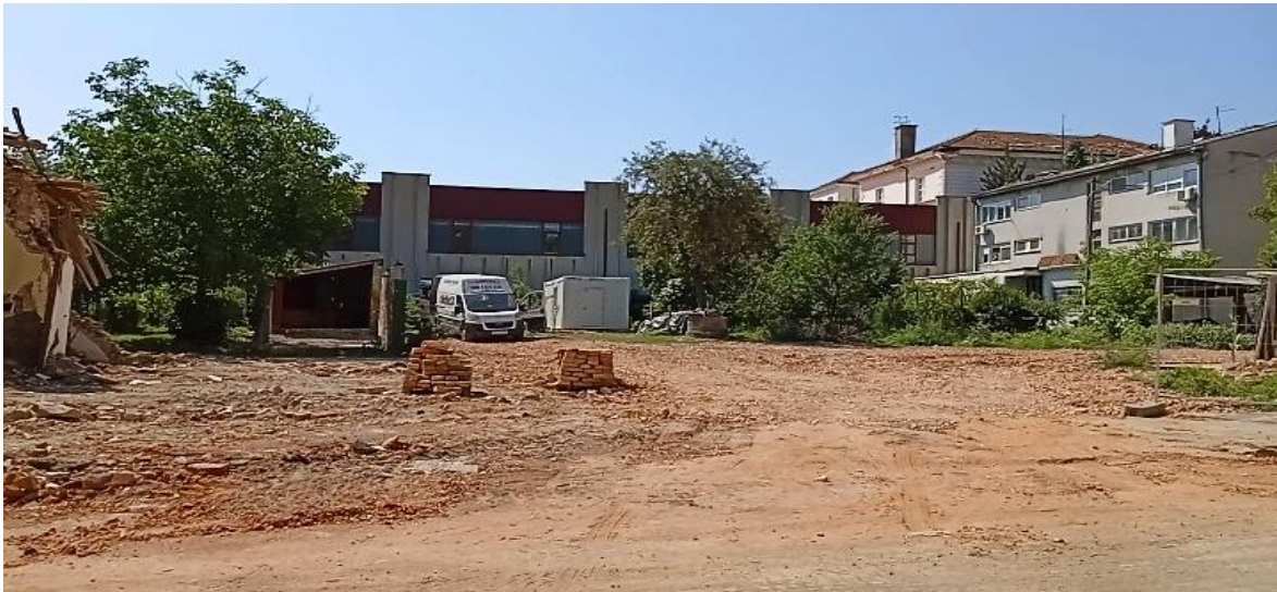
Slika 32. Zatečeno stanje objekta klasificiranog s manjim oštećenjima-2.primjer
