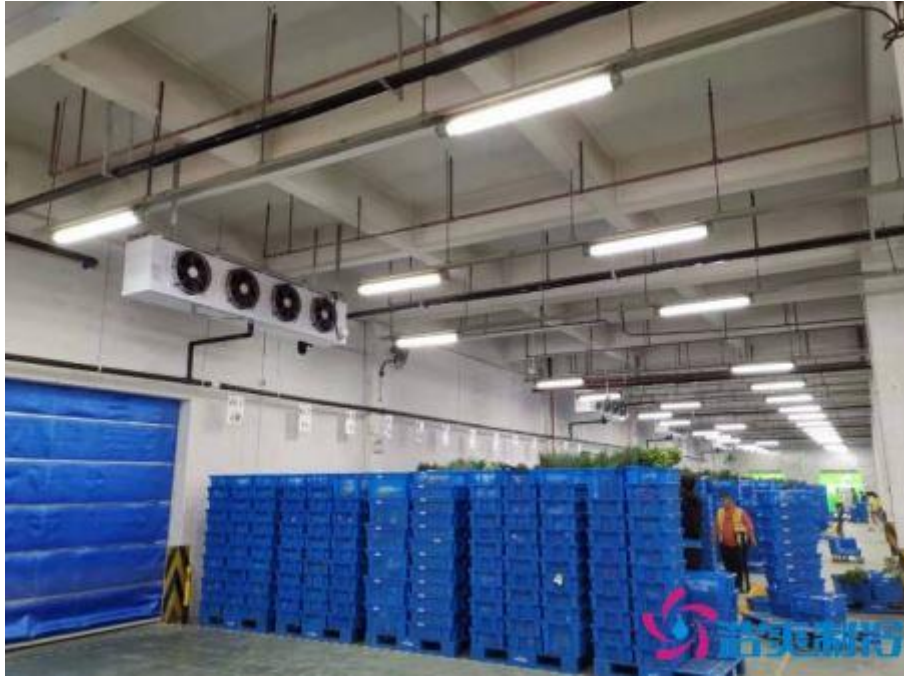
Slika 8: Unutarnji prostor hladnjače
