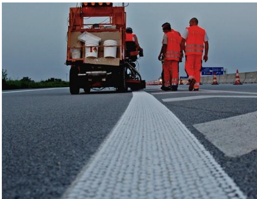
Slika 5. Aglomeratne strukturirane oznake na kolniku od hladne plastike
