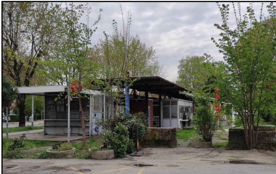
Slika 8. Ostaci armirano betonskih grudobrana na kolosijecima početnog kolodvora u Zagrebu Izvor: autor
