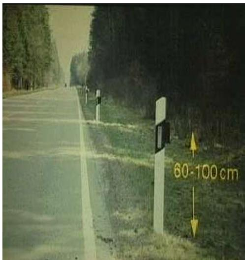
**Slika 35. Visina postavljanja senzora na smjerokazni stupić**
