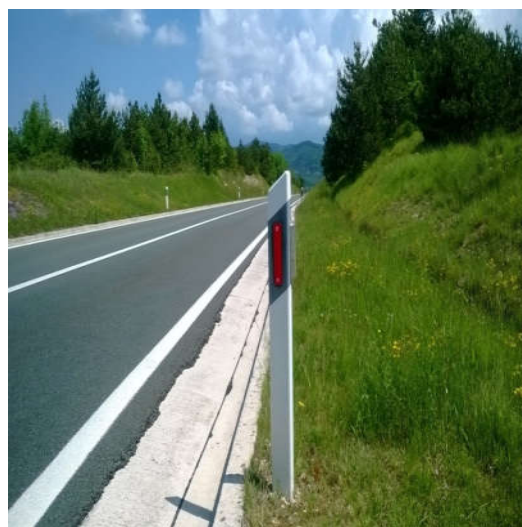
Slika 38. Optički senzor na smjerokaznom stupiću
