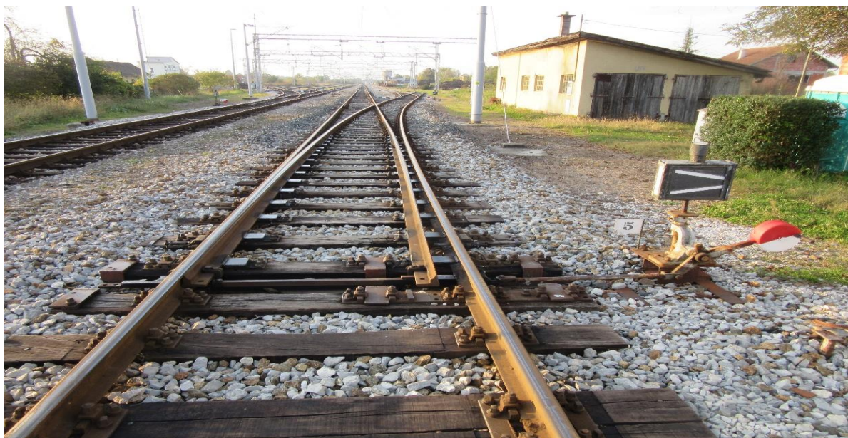
Slika 16. Skretnica broj 5 u pravilnom položaju u skretanje
