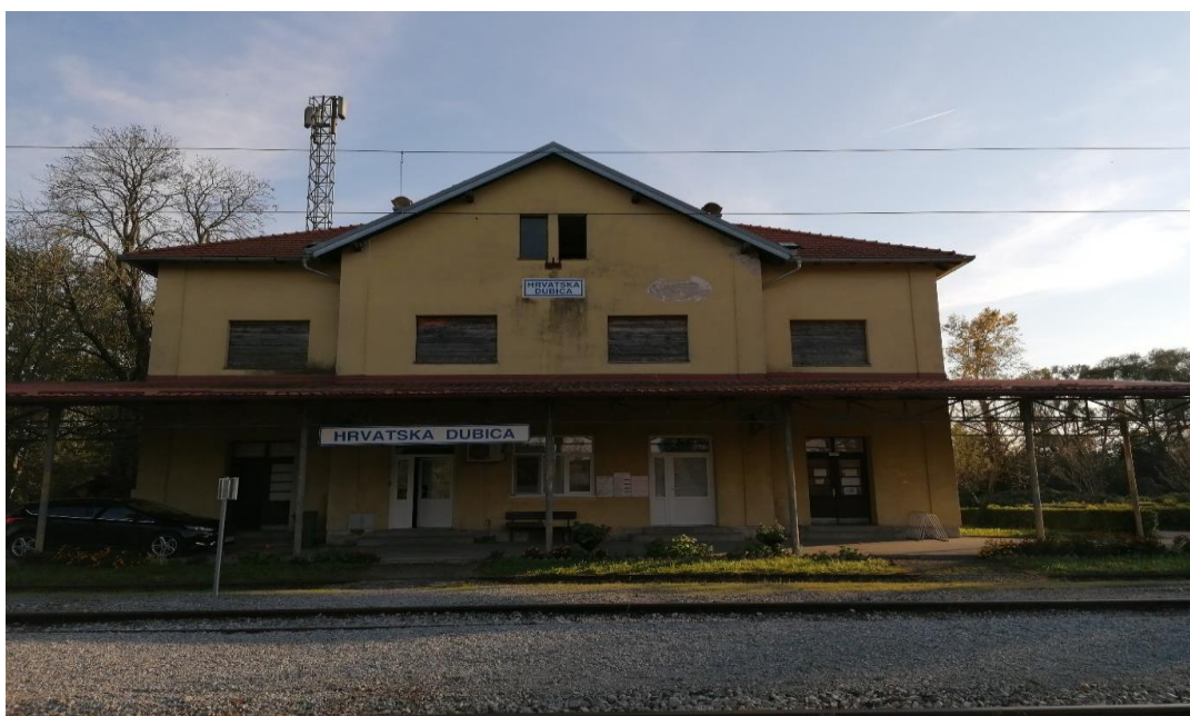
Slika 7. Kolodvorska zgrada kolodvora Hrvatska Dubica
