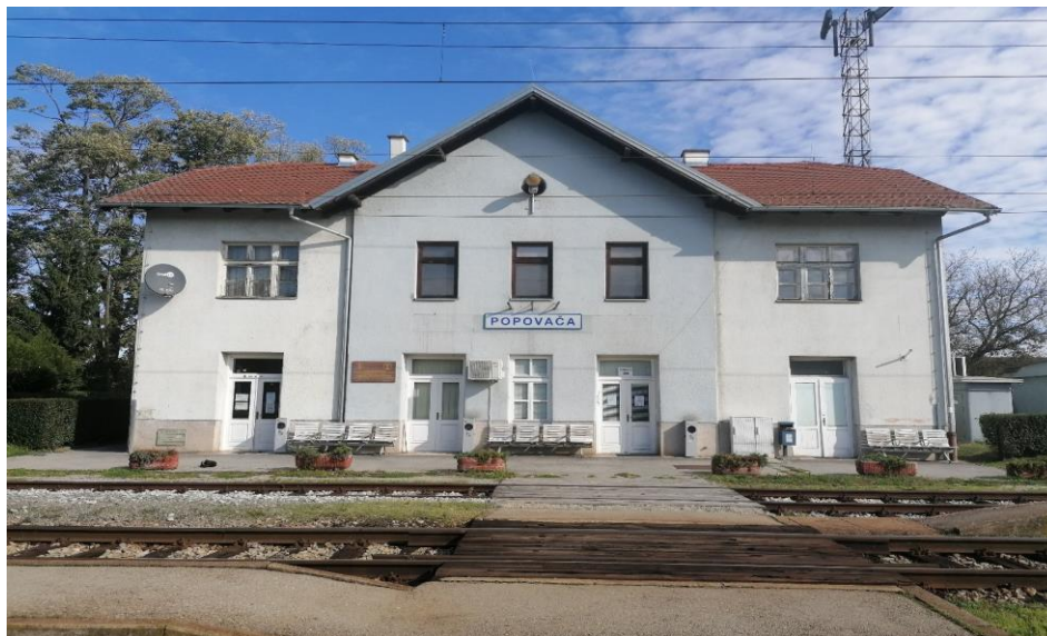
Slika 1. Kolodvorska zgrada kolodvora Popovača
