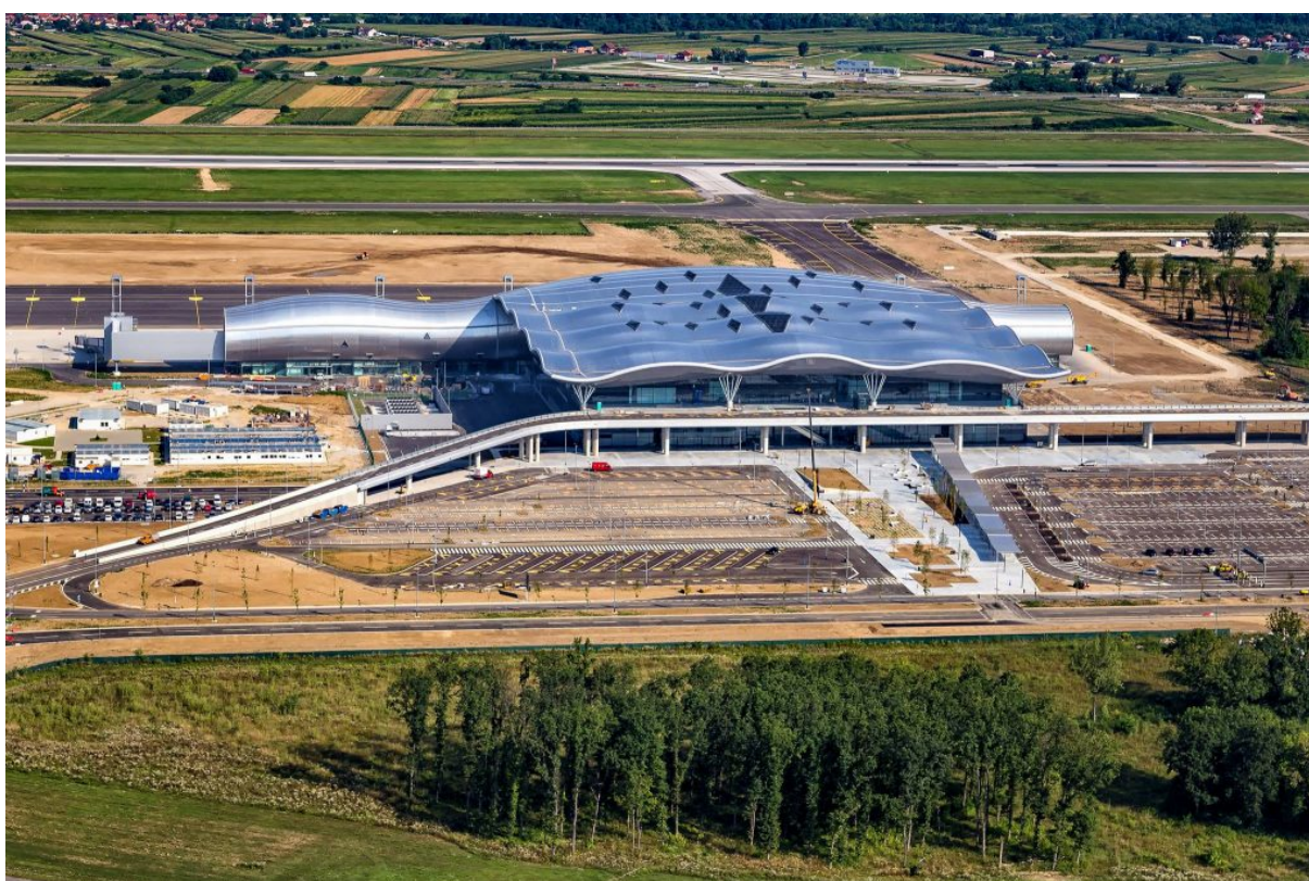
Slika 18. Prikaz krovišta novog putničkog terminala, [35]
