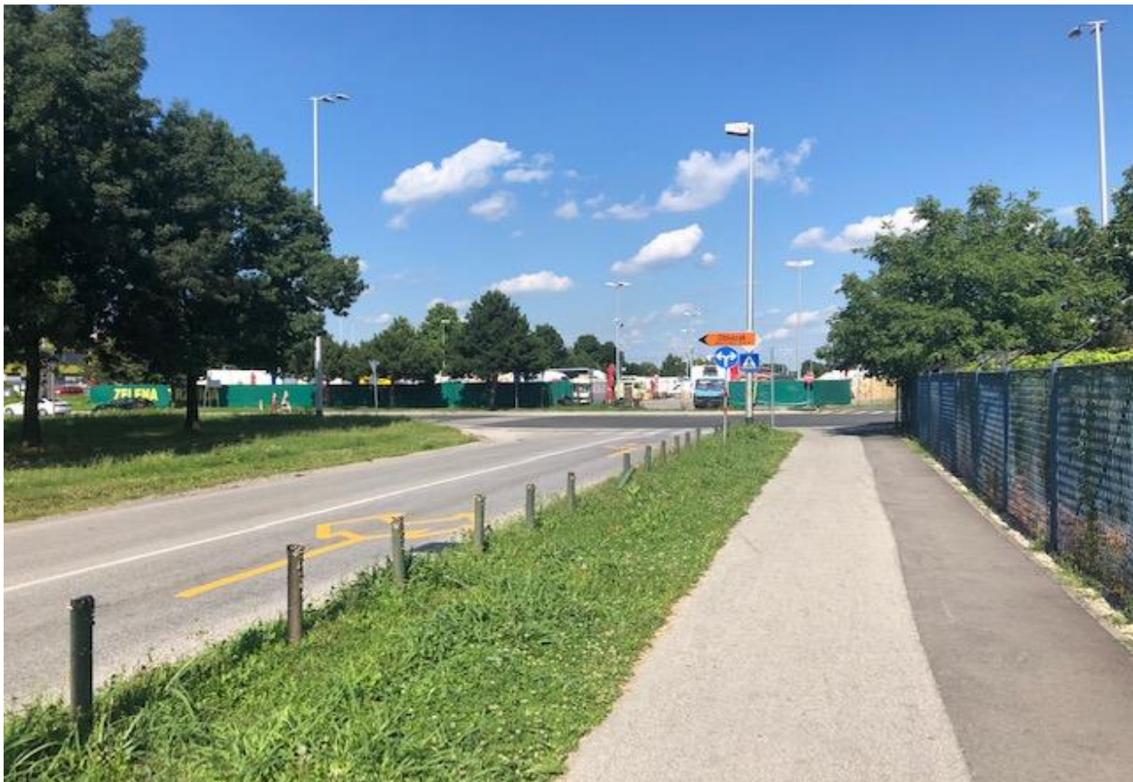
Slika 19 Zapadni privoz – Servisna cesta
