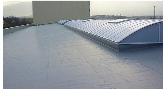
Slika 26. Krov s bijelim EPDM membranama.
