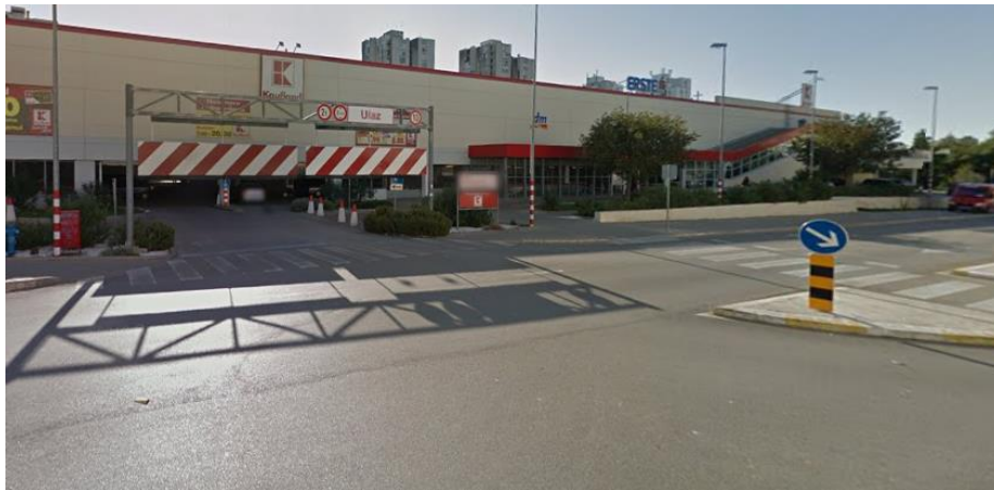
Slika 30. Prikaz lokacije 6 - ulaz u garažu centra Izvor: [8]
