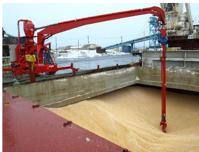
Slika 25. Brodski vakuumski iskrcavač
