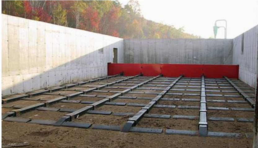
Slika 38. Bunker za skladištenje kruto rasute biomase
