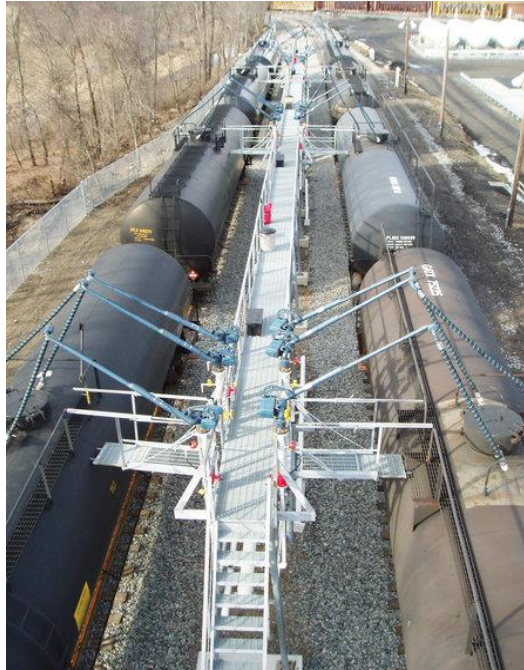
Slika 69. Ukrcaj tekuće rasute biomase za transport cisternom
