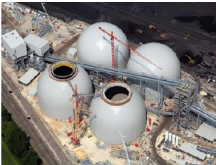
Slika 41. Kupolasta skladišta za kruto rasutu biomasu
