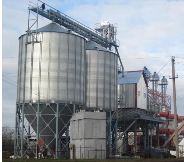
Slika 36. Silos sa suženim dnom
