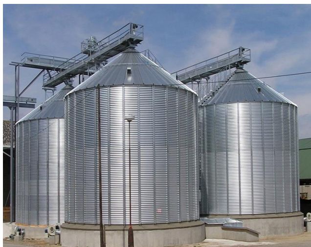
Slika 37. Silos sa ravnim dnom
