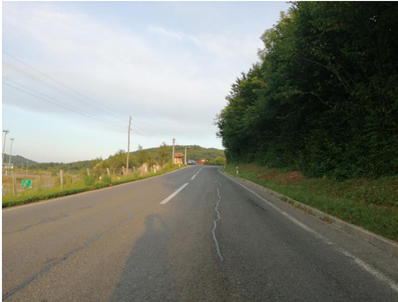
Slika 14: Prikaz dionice ceste iz smjera sjeverozapada
