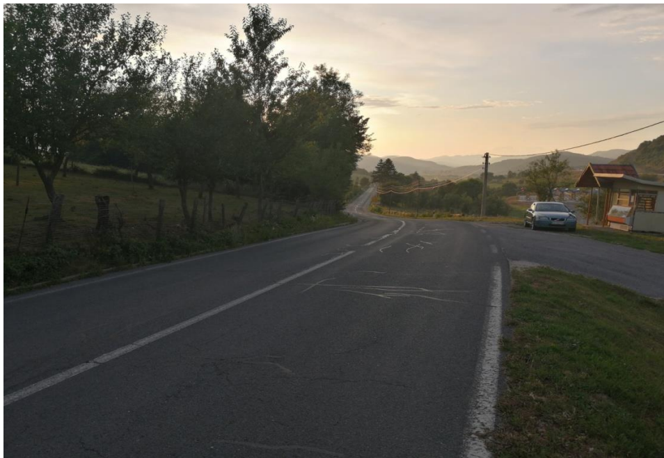
Slika 13: Dionica ceste u smjeru sjeverozapada
