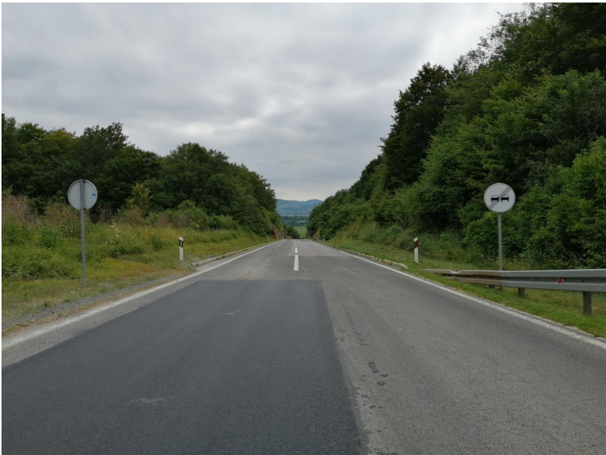
Slika 17: Dionica ceste iz smjera zapada
