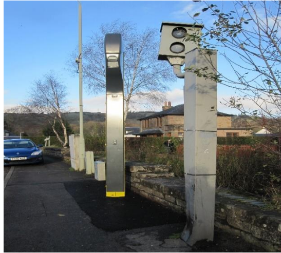
Slika 22. Kamera za nadzor željezničko-cestovnog prijelaza [27]
