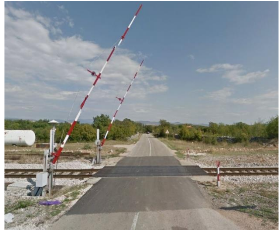
Slika 9. Željezničko cestovni prijelaz osiguran branikom [7]
