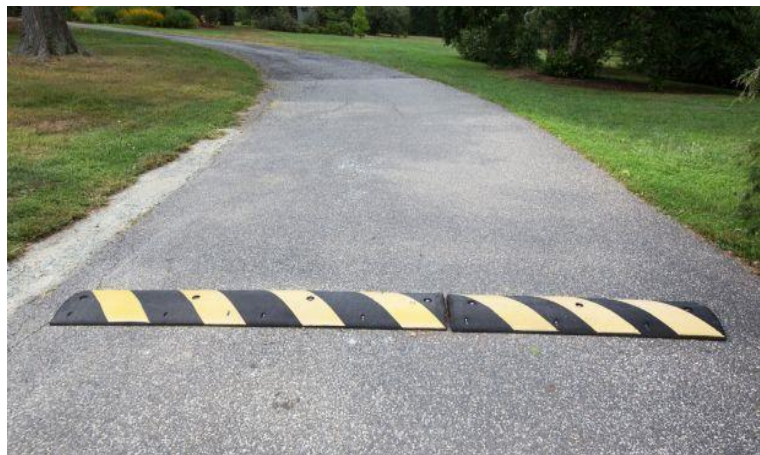
Slika 17. Uspornik na prilazu željezničko-cestovnom prijelazu [24]
