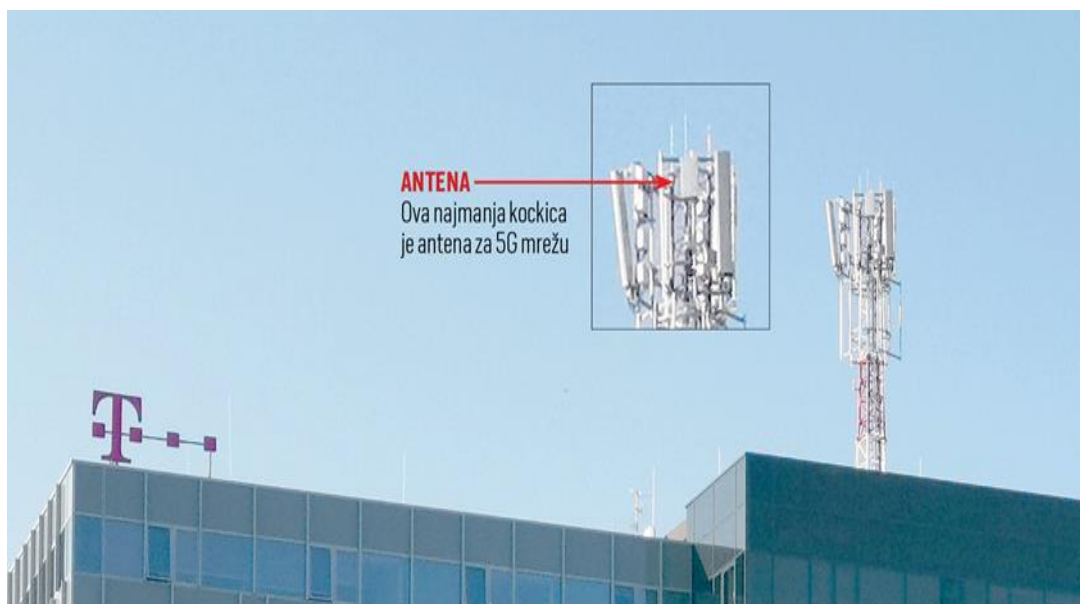
Slika 17: Prikaz antene za 5G mrežu na tornju HT-a, [76]
