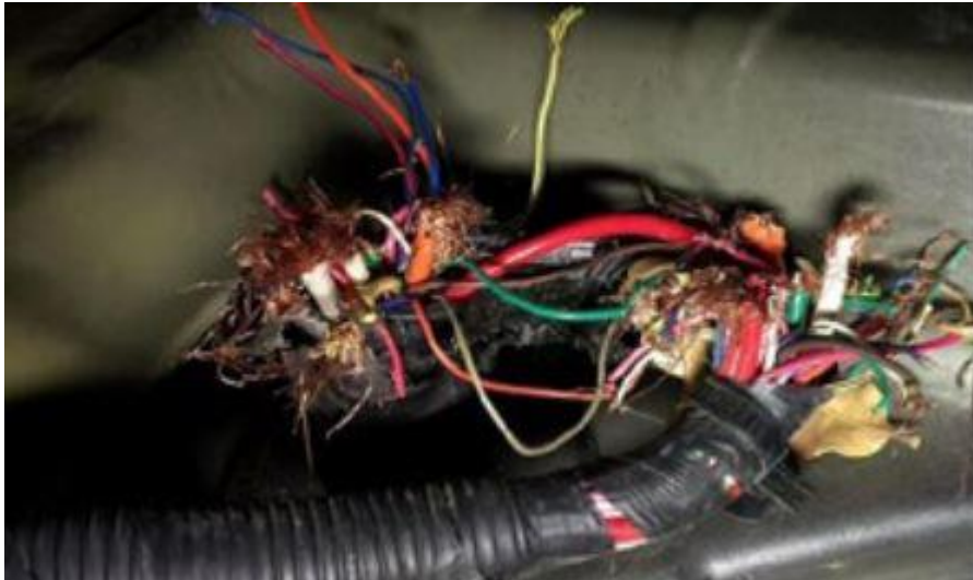
Slika 12. Oštećeni i neizolirani električni vodovi (Izvor: [8])
