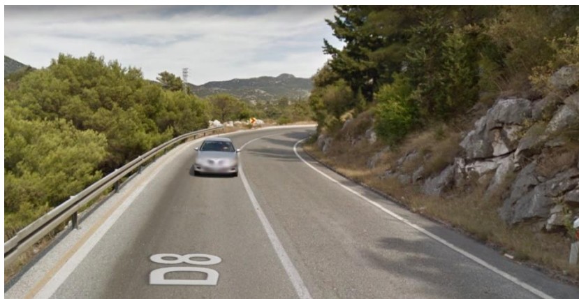
Slika 16. Prikaz lokacije 1 - zapadni prilaz Izvor: [7]
