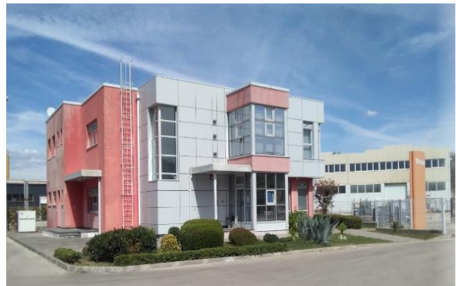
Slika 4 Upravna zgrada DC-a Metković, Vindija d.d.
