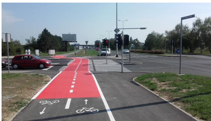
Slika 20. Primjer pravilno obilježenog biciklističkog prijelaza
