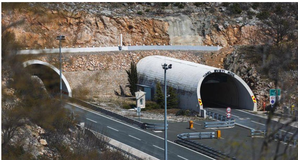
Slika 39. Portal tunela Sv. Rok, [29]
