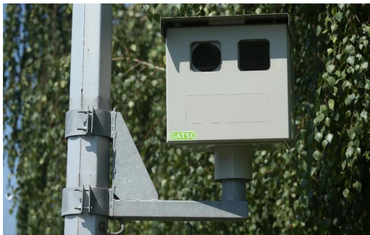
Slika 9. Kamera za nadzor brzine u Republici Hrvatskoj
