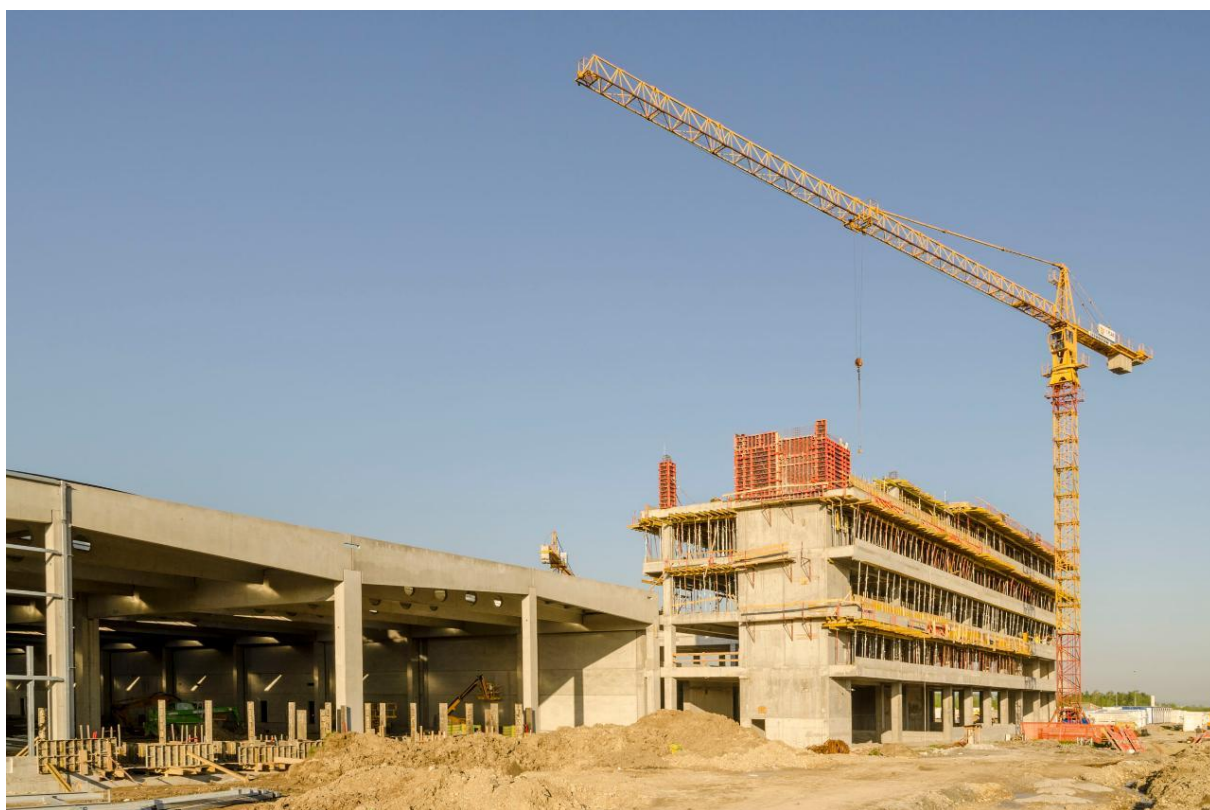
Slika 2: Izgradnja prve faze Novog sortirnog centra
