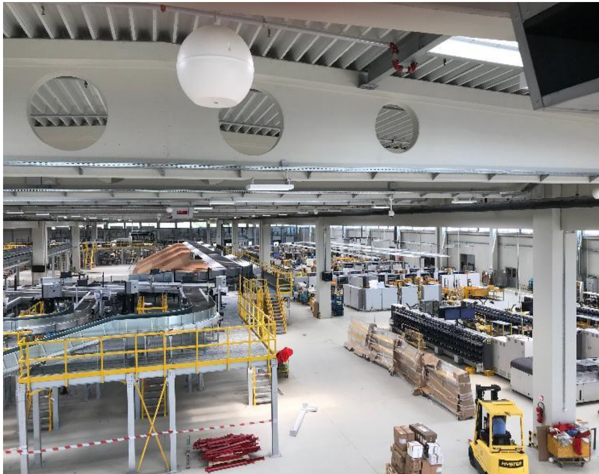
Slika 4: Unutrašnjost Novog sortirnog centra
