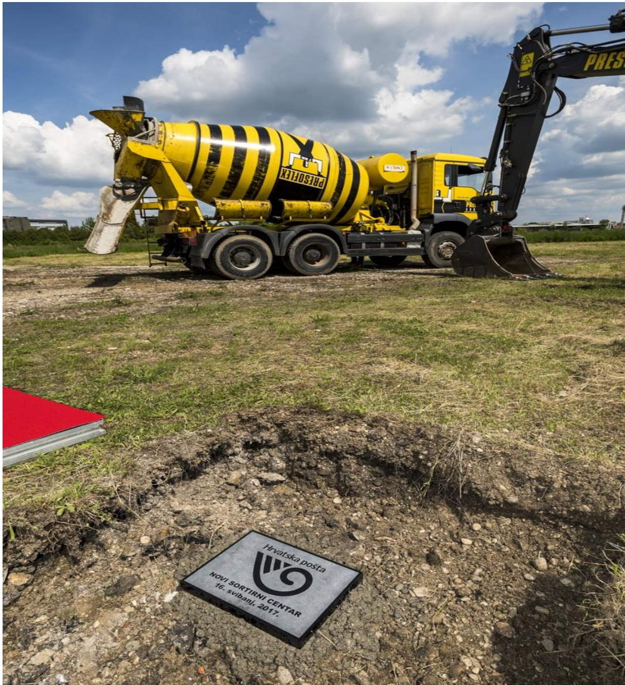
Slika 1: Kamen temeljac Novog sortirnog centra
