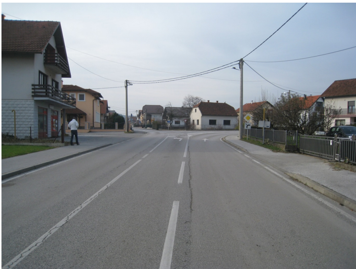
Slika 11: Prikaz stanja ceste i opreme - sjeveroistočni privoz [21]
