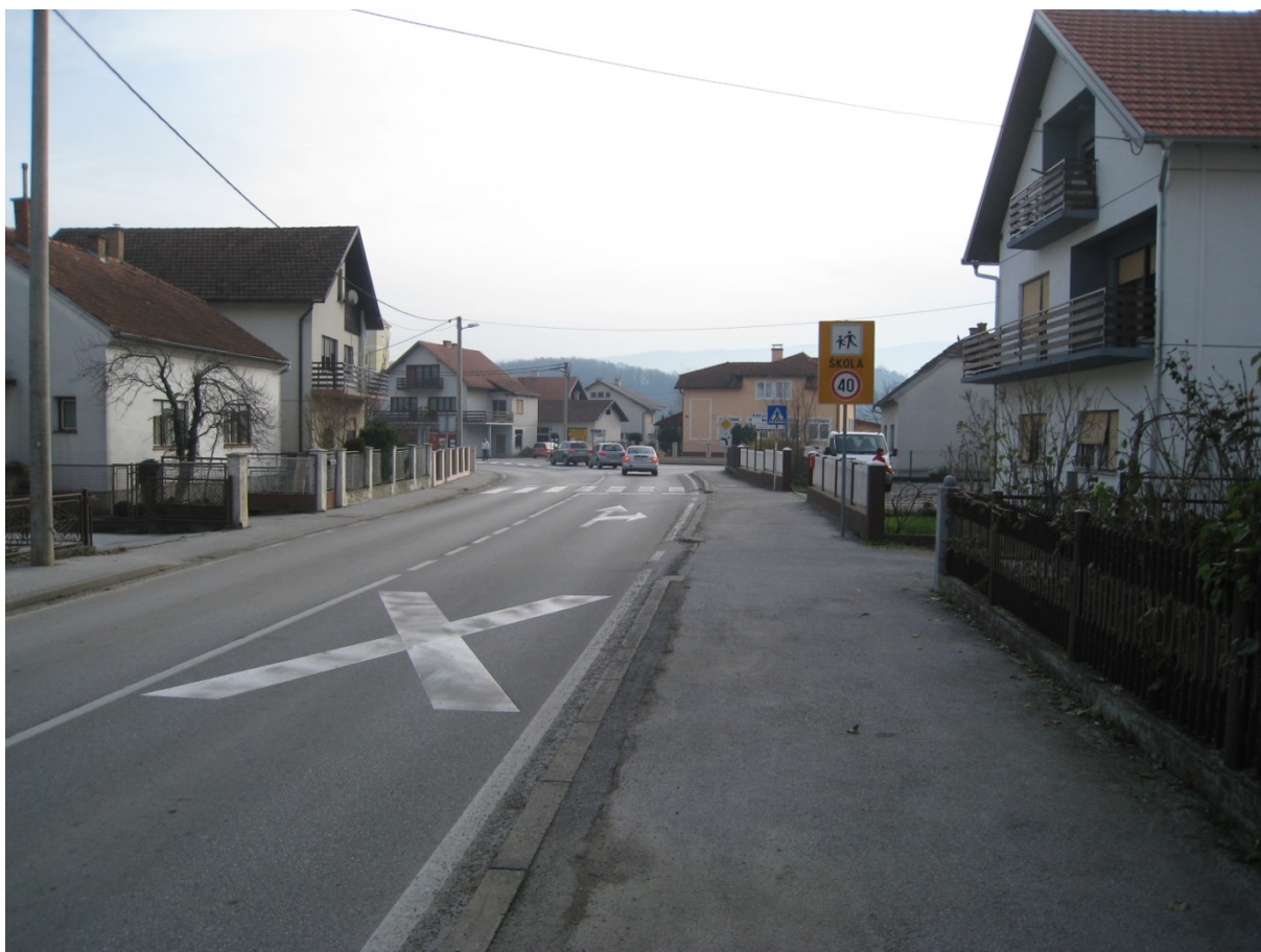
Slika 14: Prikaz stanja ceste i opreme - sjeverozapadni privoz [21]
