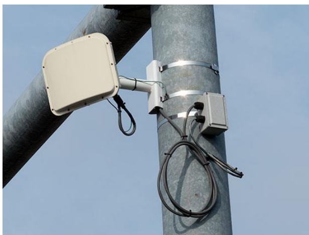
Slika 2.2-1. Mikrovalni radarski detektor, [5]
