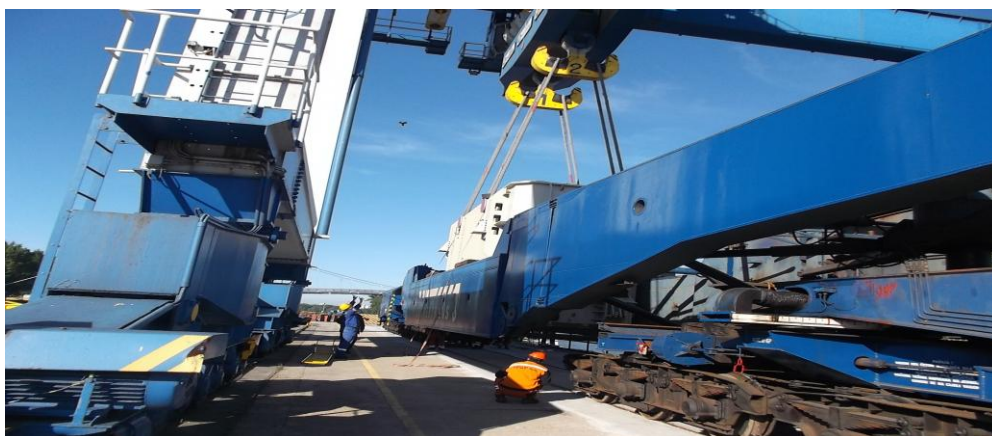
Slika 25. Iskrcaj transformatora Izvor: poduzeće ZAGREBTRANS
