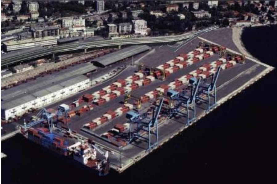
Slika 3. Kontejnerski terminal Brajdica
