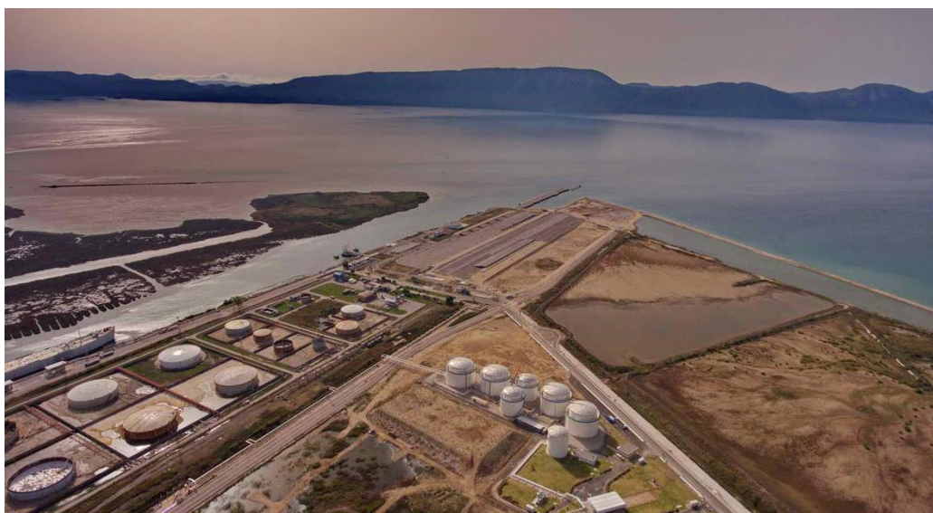
Slika 10: Područje Luke Ploče na kojem se gradi terminal za rasute terete
