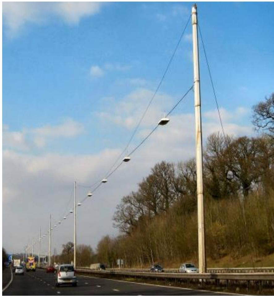
**Slika 11:** Aksijalni raspored izvora svjetlosti s nosivim žicama uzdužno na os ceste
