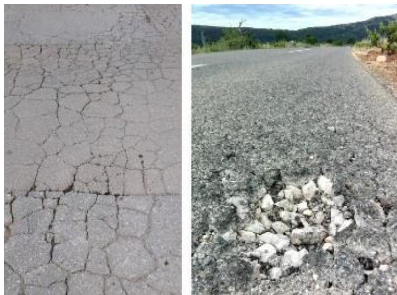
Slika 12. Pukotine na voznoj površini i udarna rupa
