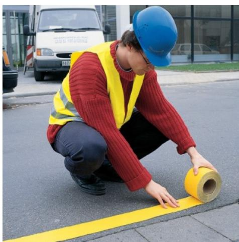
Slika 6. Pričvršćivanje trake na kolničku površinu
