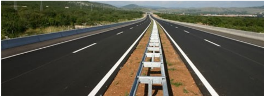
Slika 1. Prikaz uzdužnih oznaka na kolniku Izvor: [7]
