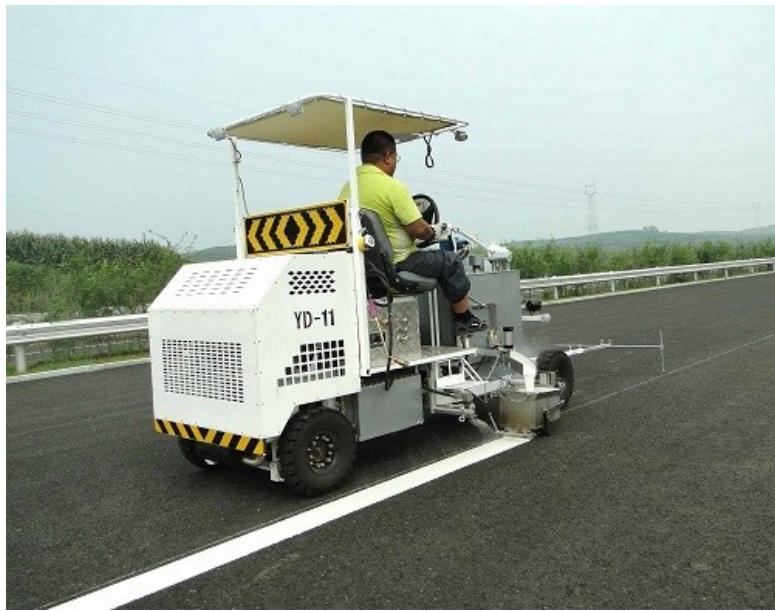
Slika 5. Proces nanošenja termoplastičnih oznaka ekstruzijom
