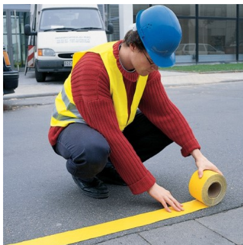
Slika 6. Pričvršćivanje trake na kolničku površinu Izvor: [17]
