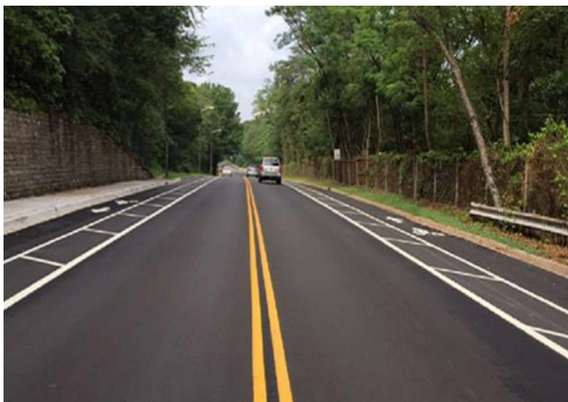
Slika 8. Oznake namijenjene optičkom sužavanju prometnih trakova uz rub kolnika Izvor: [20]
