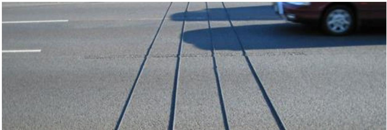
Slika 18. Automatsko brojanje prometa sa pneumatskim brojanjem
