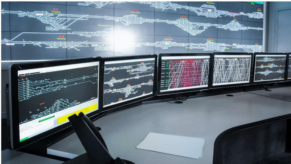
Slika 3. TMS kontrolni ured sa potrebnim sučeljima
