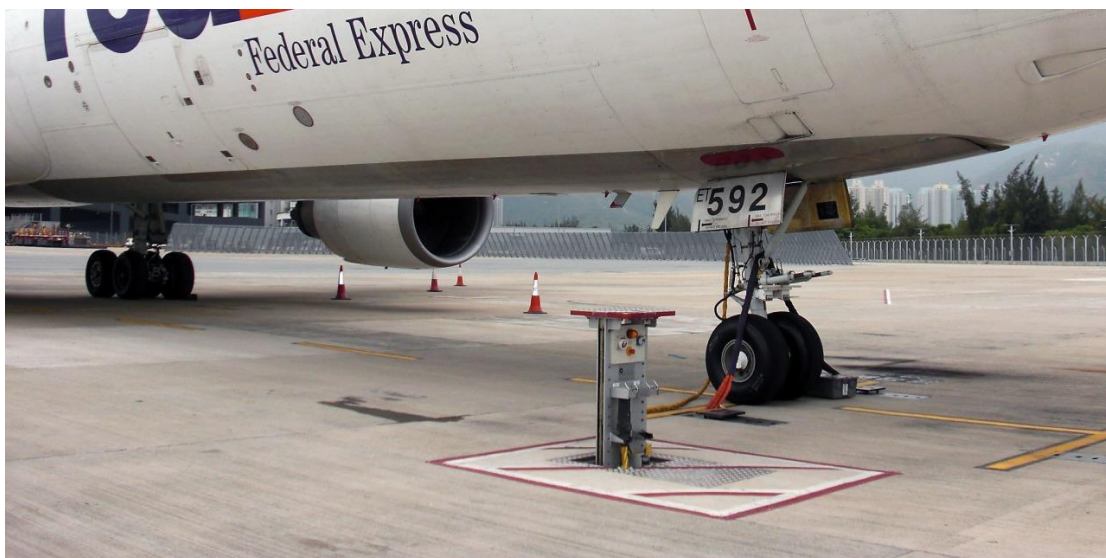
Slika 15. Fiksna oprema za gorivo, [10]
