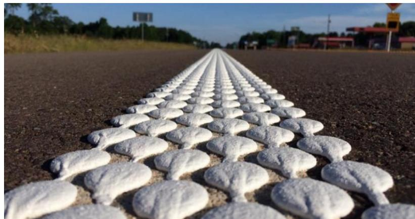
Slika 10. Primjer strukturirane oznake izrađene od termoplastike
