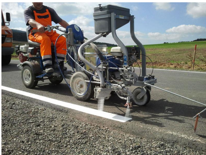
Slika 9. Prikaz nanošenja boje i staklenih perli većim strojem
