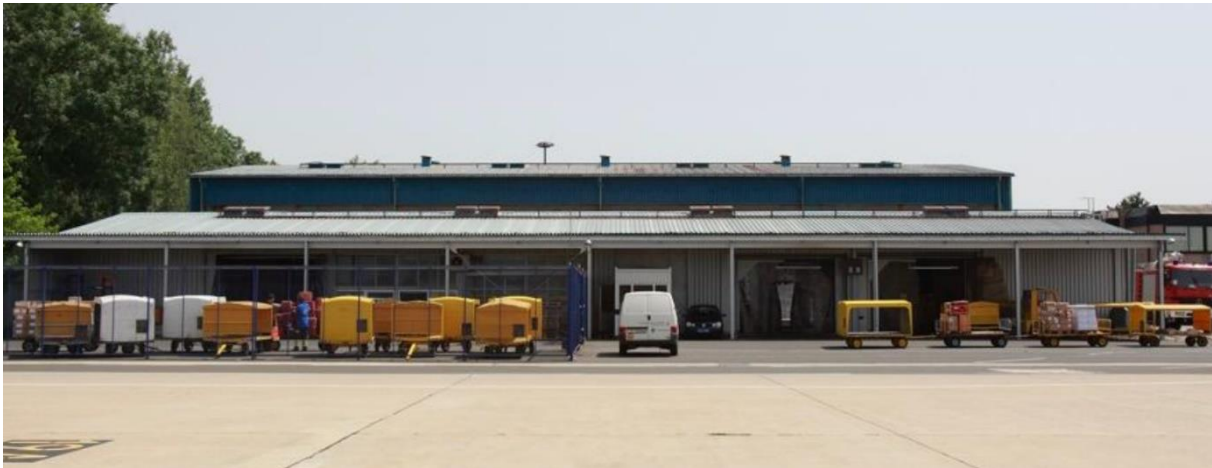
Slika 30. Cargo terminal na Zračnoj luci Franjo Tuđman
