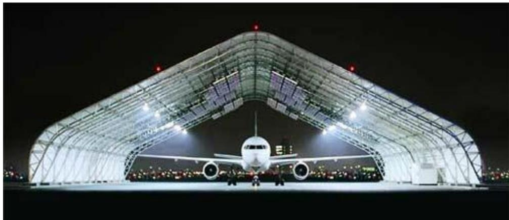
Slika 12. Sustav odleđivanja zrakoplova pomoću infracrvenog zračenja [15]
