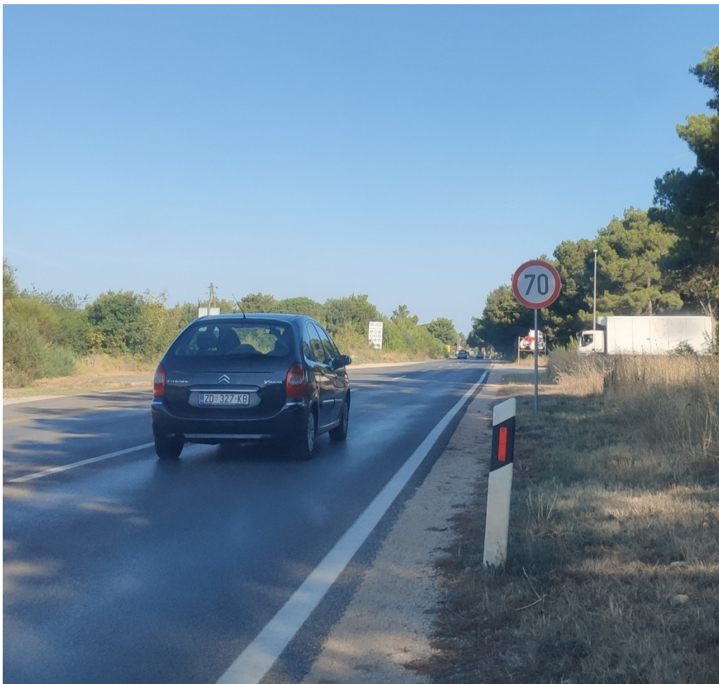
Slika 13. Trenutno postavljeno ograničenje brzine na predmetnom raskrižju
