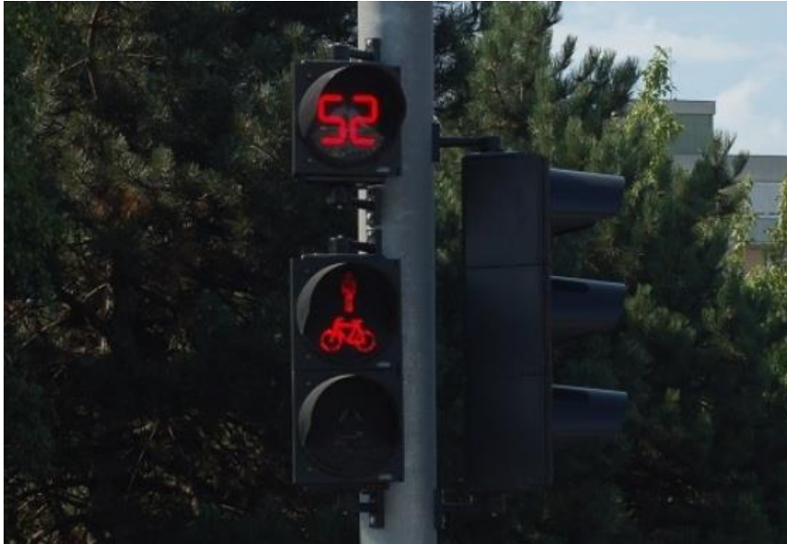
Slika 31. Brojač vremena na semaforskom uređaju, [9]
