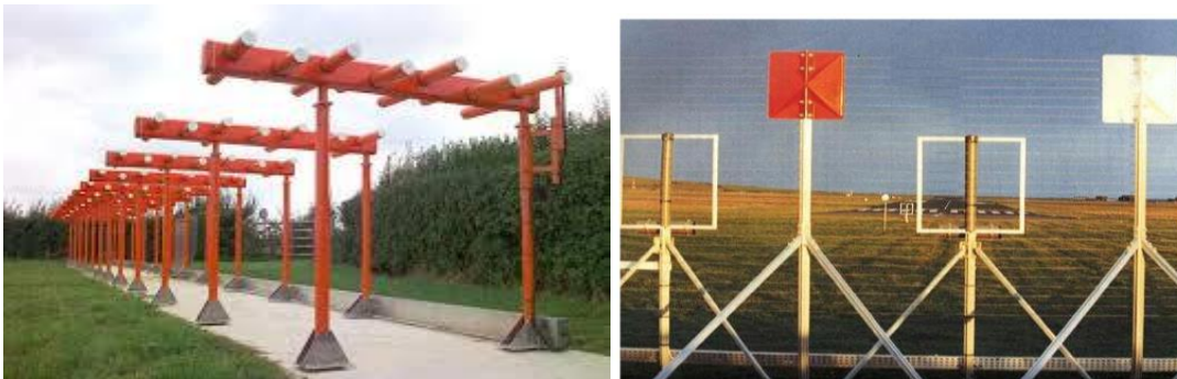
Slika 5. Primjer log-periodske antene i četvrtaste antene. [4]
