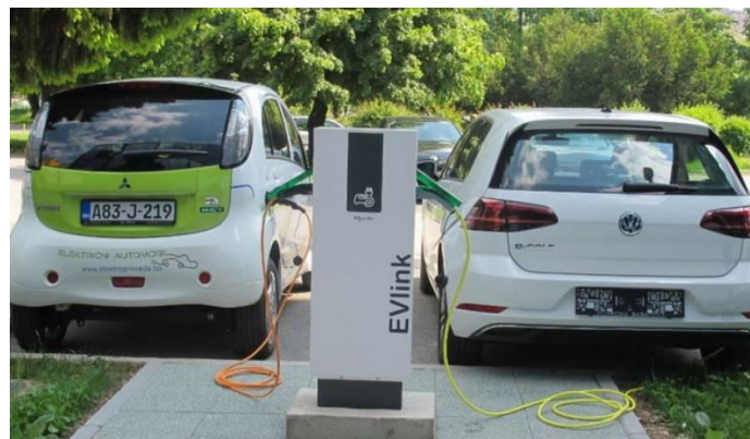
Slika 17.: „Mini stanica“ i punjenje električnog automobila punjačem
