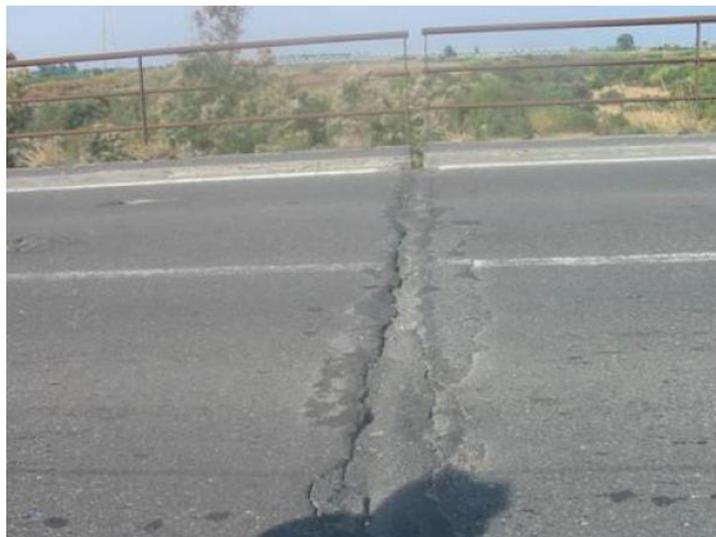
**Slika 8. Oštećeni spoj na mostu**
