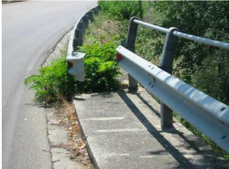
**Slika 9. Neusklađenost zaštitne ograda uz kolnik i na mostu - bez spoja**
