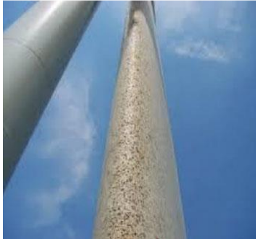
Slika 32. Prljavština, kukci i ptičji izmeti na lopaticama
